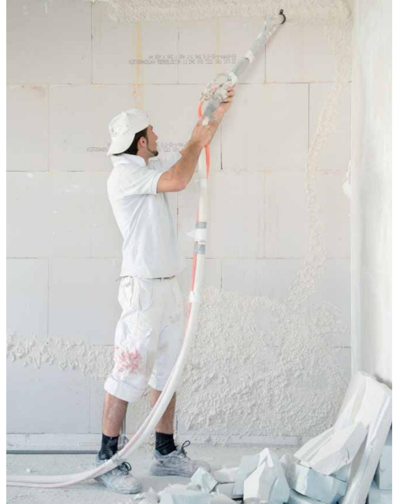
*/ Diese Wand ist so gut wie fertig. Unser Mitarbeiter trägt den Maschinenputz auf und zieht ihn glatt. Anschließend wird sie von den Malerkollegen gestrichen.*
