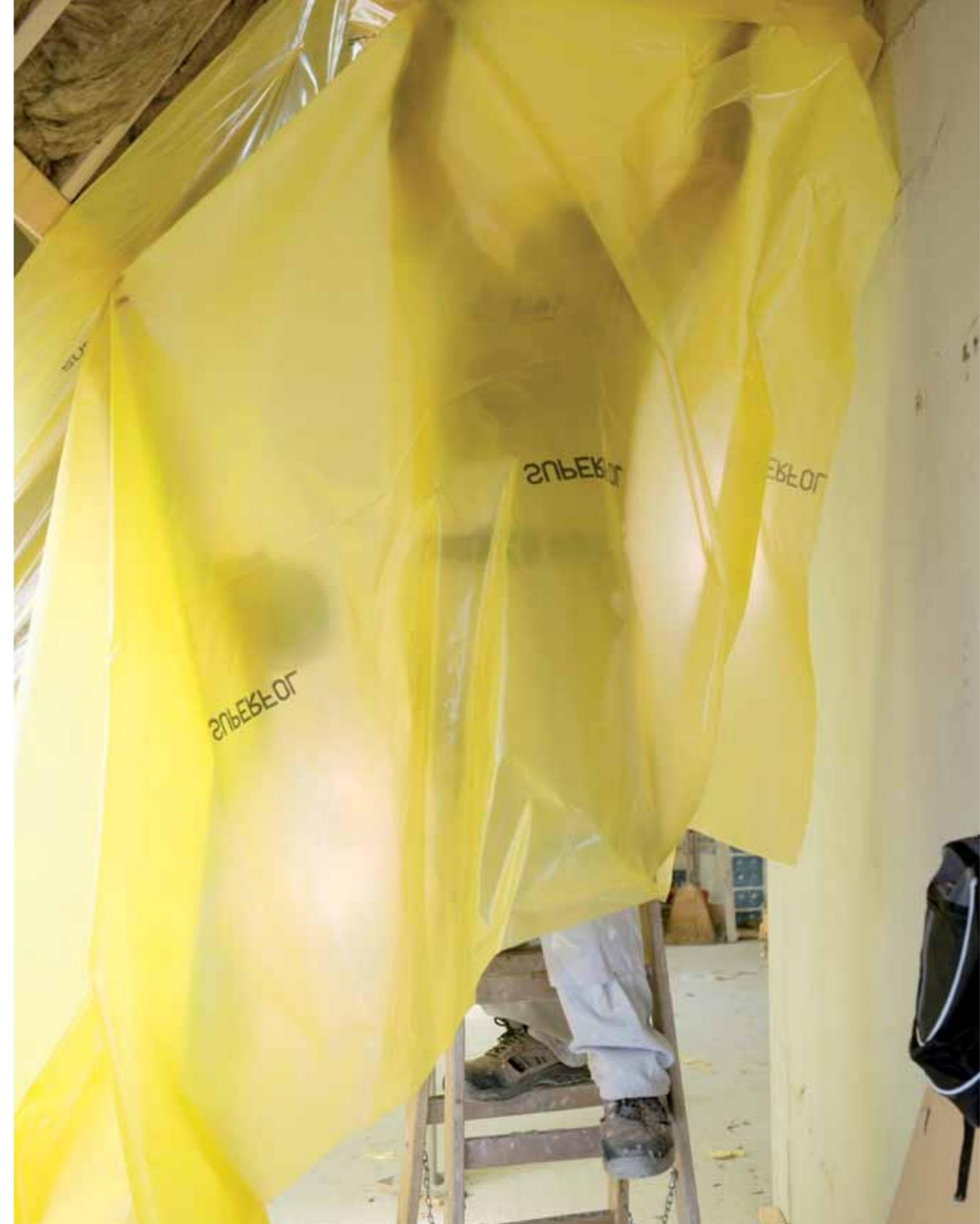
*/ Über die Innendämmung wird eine Dampfsperrenfolie gezogen, damit keine Feuchtigkeit an den Dämmstoff gelangt. Im Anschluss wird die Lattung angebracht und mit Gipskarton beplankt.*
