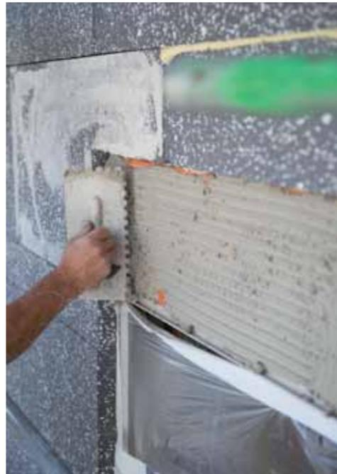
*/ Über die Vollwärmeschutzplatten kommt zuerst die Gewebespachtelung und danach der Putz.*
